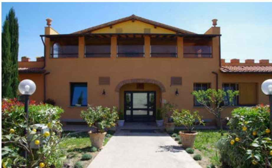
Centro diurno “Castello”
