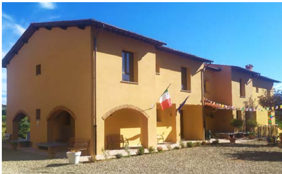
Residenza sanitaria per minori “Il Fortino”
