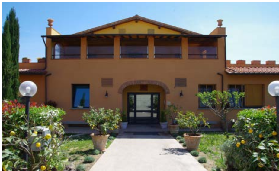
Centro diurno “Castello”
